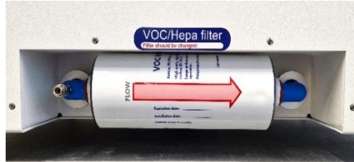
12.3 pav. Tinkamai įdėtas LOJ ir HEPA filtras
